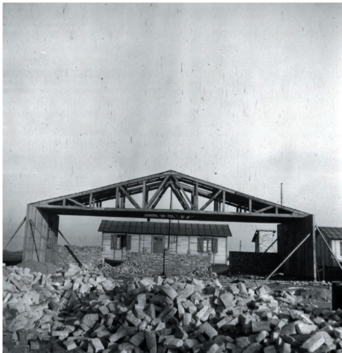
Constructions provisoires de récupération , 15 décembre 1945 Service photographique du MRU, anonyme. Photothèque de la DICOM © MEDDE / MLETR
