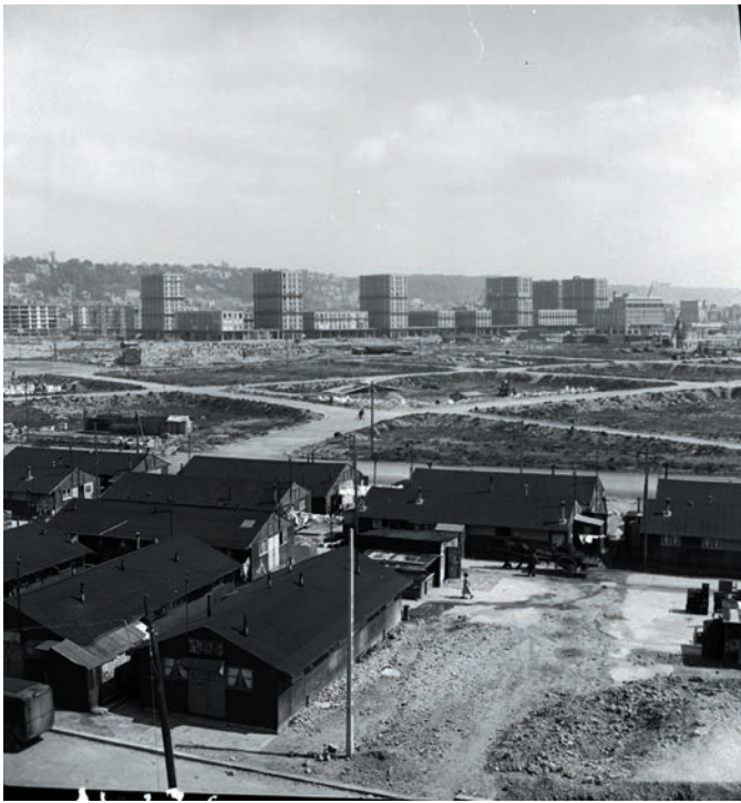
Chantiers ISAI [Immeuble sans affectation individuelle], atelier Perret, mai 1951 Service photographique du MRU, Henri Salesse. Photothèque de la DICOM © MEDDE / MLETR
