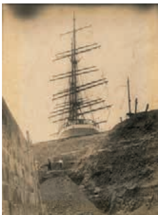
1. LEFLOCH Rémi Granville, les travaux du port. Terre plein et mât du Bellecq 1924. Tirage sur papier argentique Granville, musée du Vieux Granville
