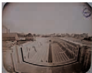
7. ANONYME Le Havre, allongement de la grande forme de radoub (n° 4), quai est du bassin de l'Eure . 1901. Photographie Le Havre, archives municipales. © Charles Maslard
