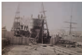
6. ANONYME Le Havre, achèvement des travaux de réparation de l'écluse de l'Eure, entre les bassins Vauban et de l'Eure . 1890 Éditeur : Port du Havre, atelier photographique. Tirage albuminé Le Havre, archives municipales. © Charles Maslard
