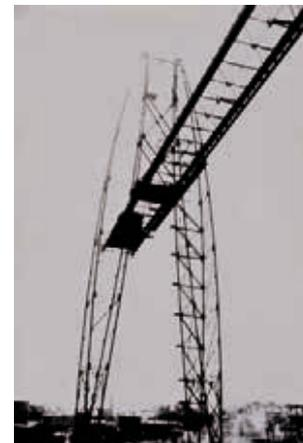
squelettiques de sa silhouette dégingandée sont immédiatement reconnaissables. En France, 50 mètres séparent la hauteur d'eau à marée haute du tablier, permettant ainsi le passage des plus gros voiliers. Leur nacelle suspendue permet aux piétons et aux véhicules de traverser les fleuves. Après la guerre de 1914, ces géants des rives disparaissent, victimes de l'augmentation du trafic automobile et de l'extinction progressive de la marine à voile.
