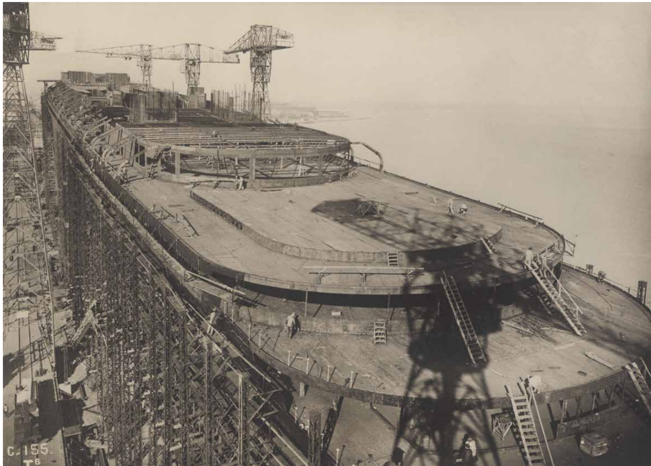
Anonyme, (Chantiers de Penhoët), Normandie en finition à Saint-Nazaire : ponts en terrasse de la poupe, 7 octobre 1932 Épreuve gélatino-argentique, 20 x 25 cm, Le Havre, French Lines & Compagnies, patrimoine maritime et portuaire
